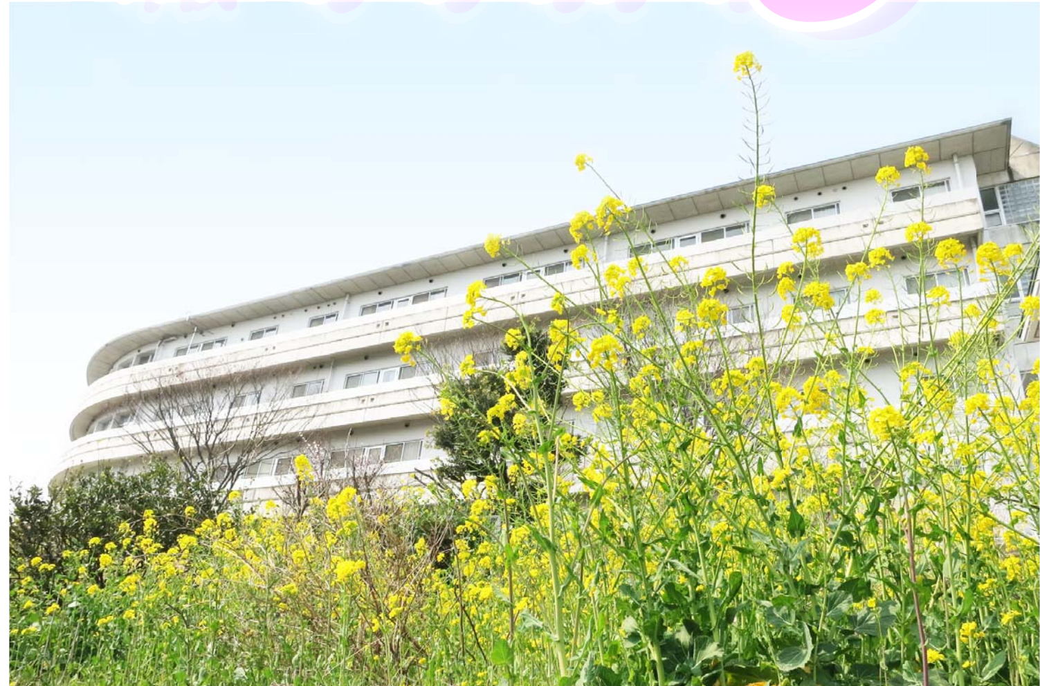
病院東側より
