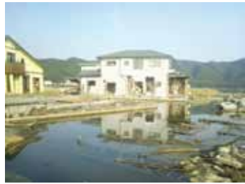
復旧されていない道路
